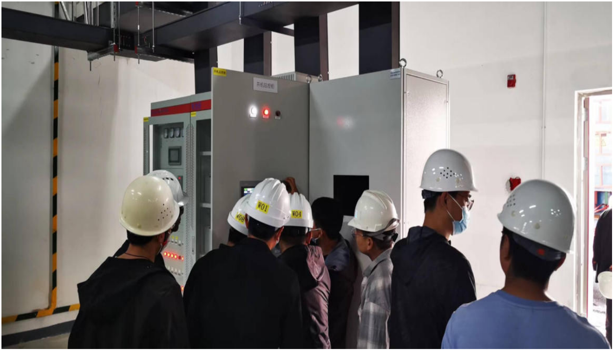
兰州新区大数据中心柴油发电机控制系统
