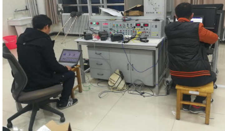
基于物联网的水厂高位水池远程控制系统
