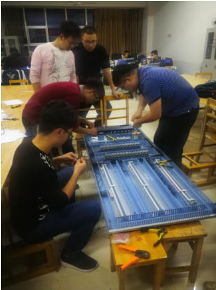
工程项目电气柜成套
