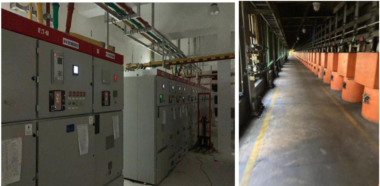
浇筑站冷却循环泵控制柜
