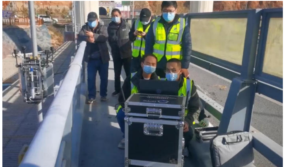
刘家峡大桥桥梁检测
