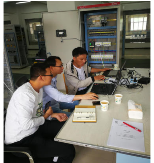
云南神火电解铝阳极输送机自动化控制系统调试
