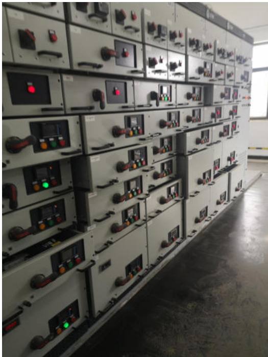
隧道泥浆泵控制柜
