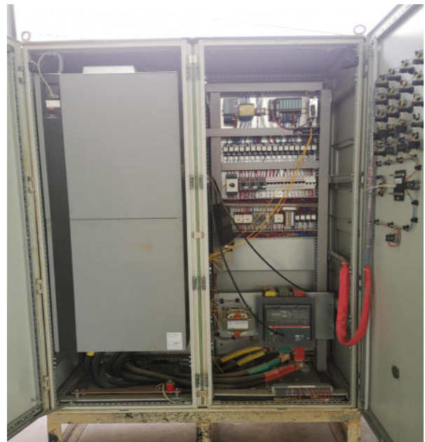
隧道泥浆泵控制柜
