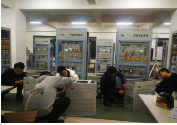
团队自制 PLC 实验台
