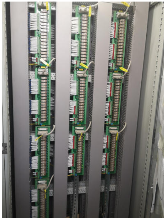
隧道泥浆泵控制柜
