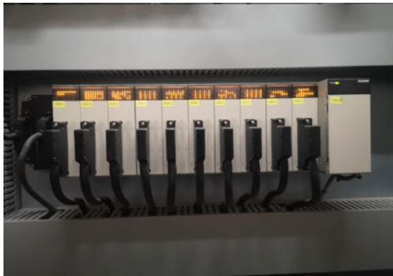
隧道泥浆泵控制柜
