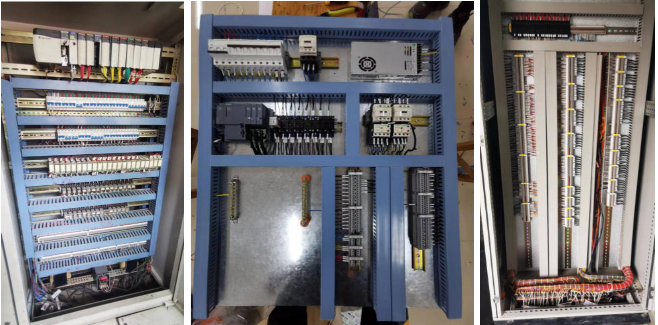
浇筑站冷却循环泵控制柜
